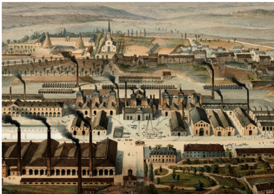
Illustration 1 – Le Creusot en 1847 : vue prise au nord, lithographie d'après l'aquarelle de Trémaux.
